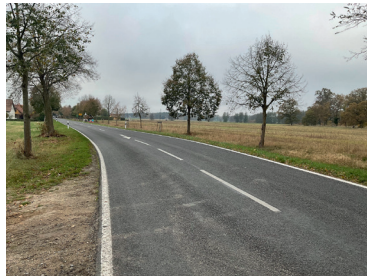
Ortszufahrt Steinstr., Baugrund- stücke rechtsseits
